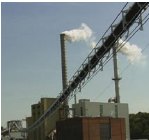
In Lenzing (Oberösterreich) wurde ein RopeCon zur Förderung von Hackschnitzeln von der Firma Doppelmayr installiert. Dieses Gurtfördersystem ermöglicht es der Industrie, kostengünstiger und umweltschonender zu arbeiten.
