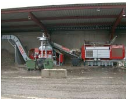
Der Prototyp der Versuchsanlage.
