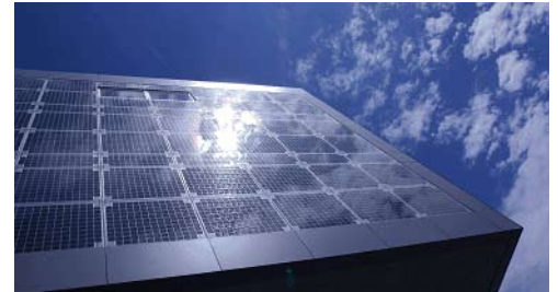
Photovoltaikanlage an einer Gebäudefassade.
