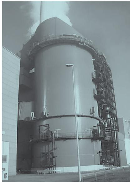
Sprühturm der Rauchgasentschwefelungsanlage eines kalorischen Großkraftwerkes (Heyden, Deutschland)
