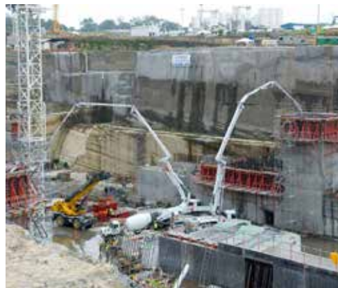
Ultrahochfeste Betonpumpenausleger im Einsatz (Schwing GmbH)
